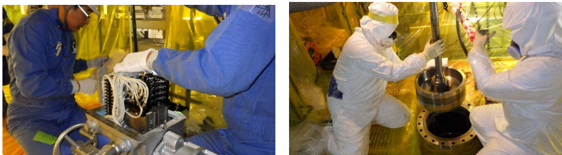
図 3.1.2 1次冷却材主要弁分解点検の様子
